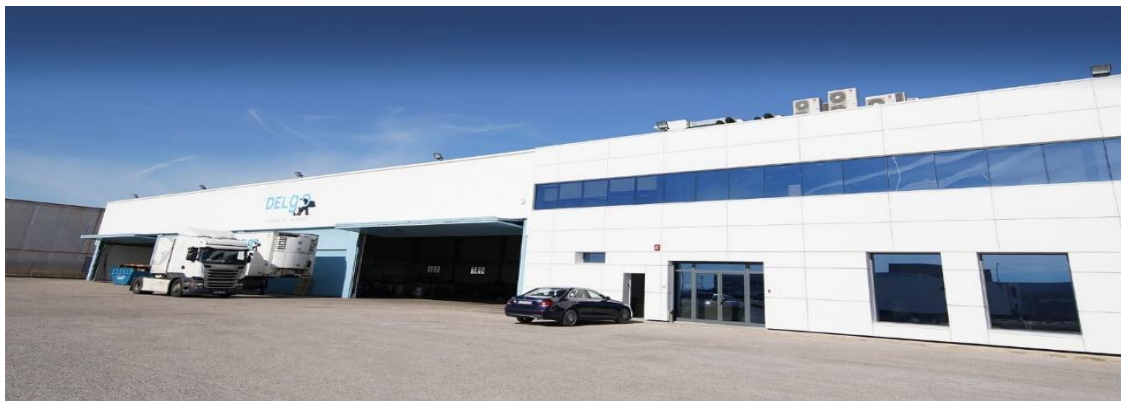
Vista general de la instalación
